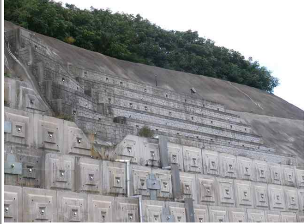
배수관, 배수로 전경
