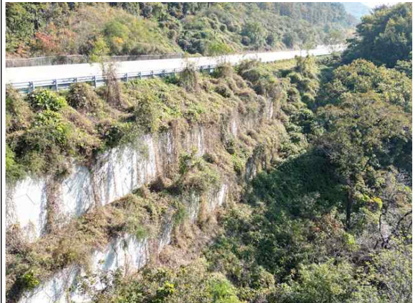
상부 성토부 전경
