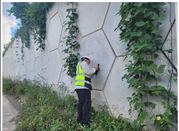
경사계를 이용한 경사도 측정
