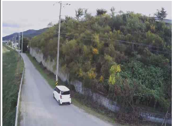
상부 성토부 전경
