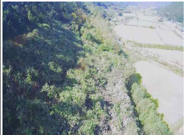
상부 성토부 전경
