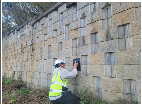
경사계를 이용한 경사도 측정
