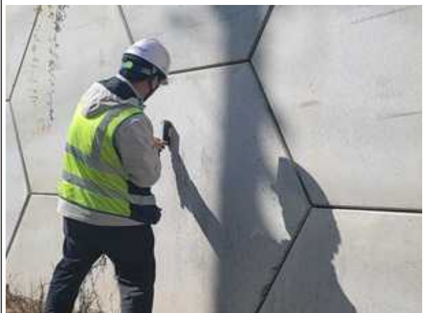
경사계를 이용한 경사도 측정
