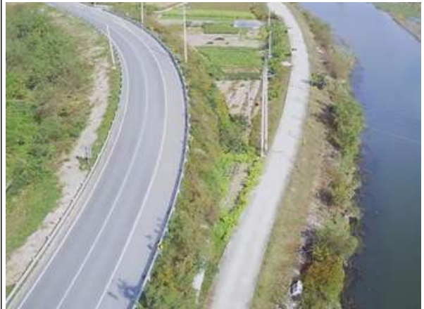
상부 성토부 전경
