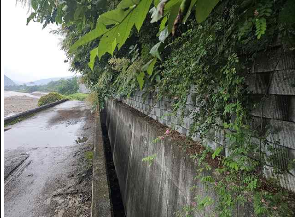
하부 배수로 전경
