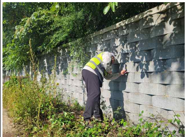
경사계를 이용한 경사도 측정
