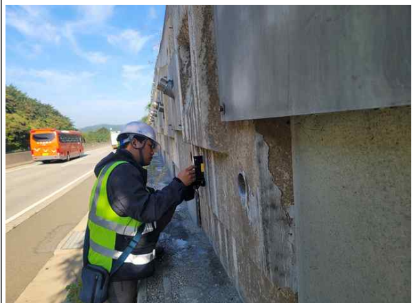
경사계를 이용한 경사도 측정
