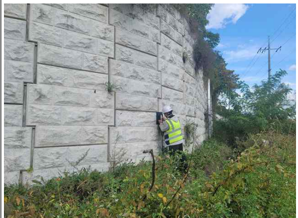
경사계를 이용한 경사도 측정
