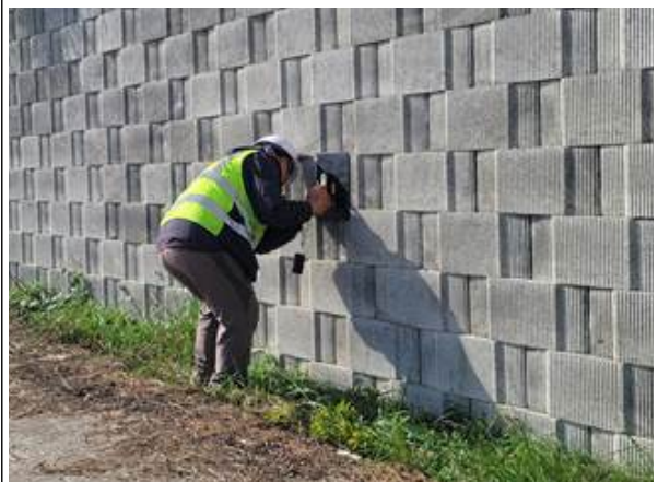
경사계를 이용한 경사도 측정
