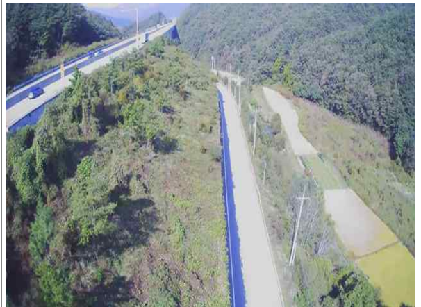
상부 성토부 전경
