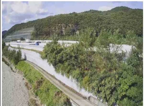
상부 성토부 전경
